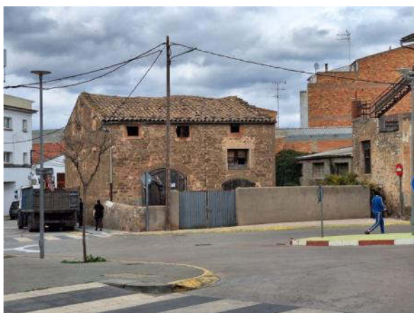
Edifici de Cal Domenjó, per rehabilitar
